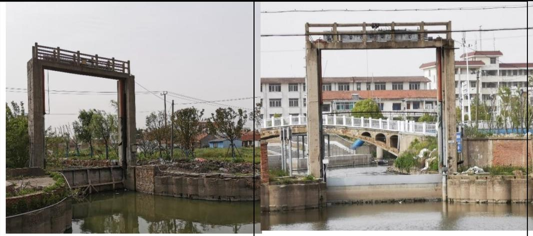
十六总套闸净宽现状为 6.0 (6.5) m, 闸底坎高程为-0.45m, 闸室成丁字形, 东西长 100m, 南北长 96m, 底宽 8.14m, 混凝土护坡, 坡度 1:1.8, 设计流量 25m<sup>3</sup>/s, 与《启东市水系规划》(2021-2035) 不相适应, 同时因建设年代久远, 现十六总套闸无法正常运行, 不能发挥防洪除涝和活水引流的作用。
